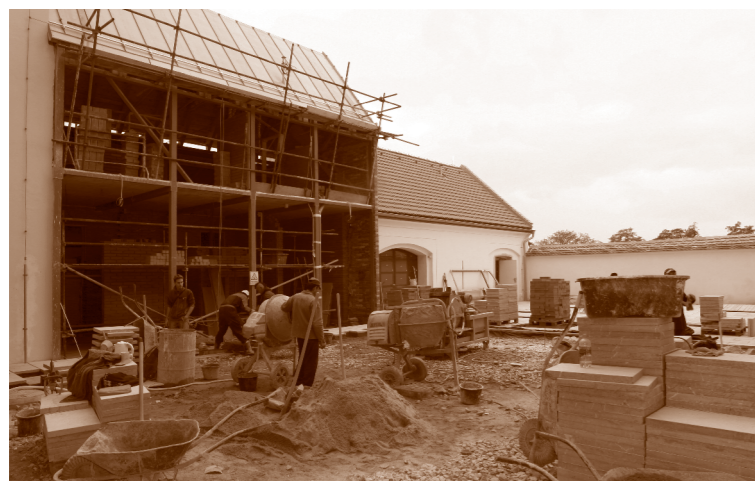
Rekonstrukce zámku, novostavba propojovacího objektu s provozním zázemím, 2006–2008
