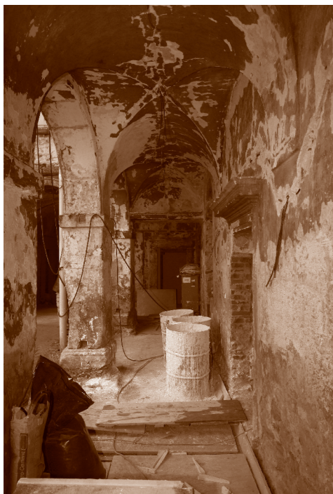
Rekonstrukce zámku, arkády v přízemí, 2006–2008
