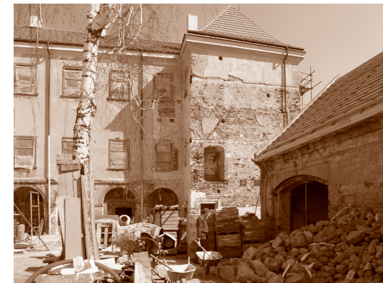
Rekonstrukce zámku, východní křídlo a kočárovna, 2006–2008
