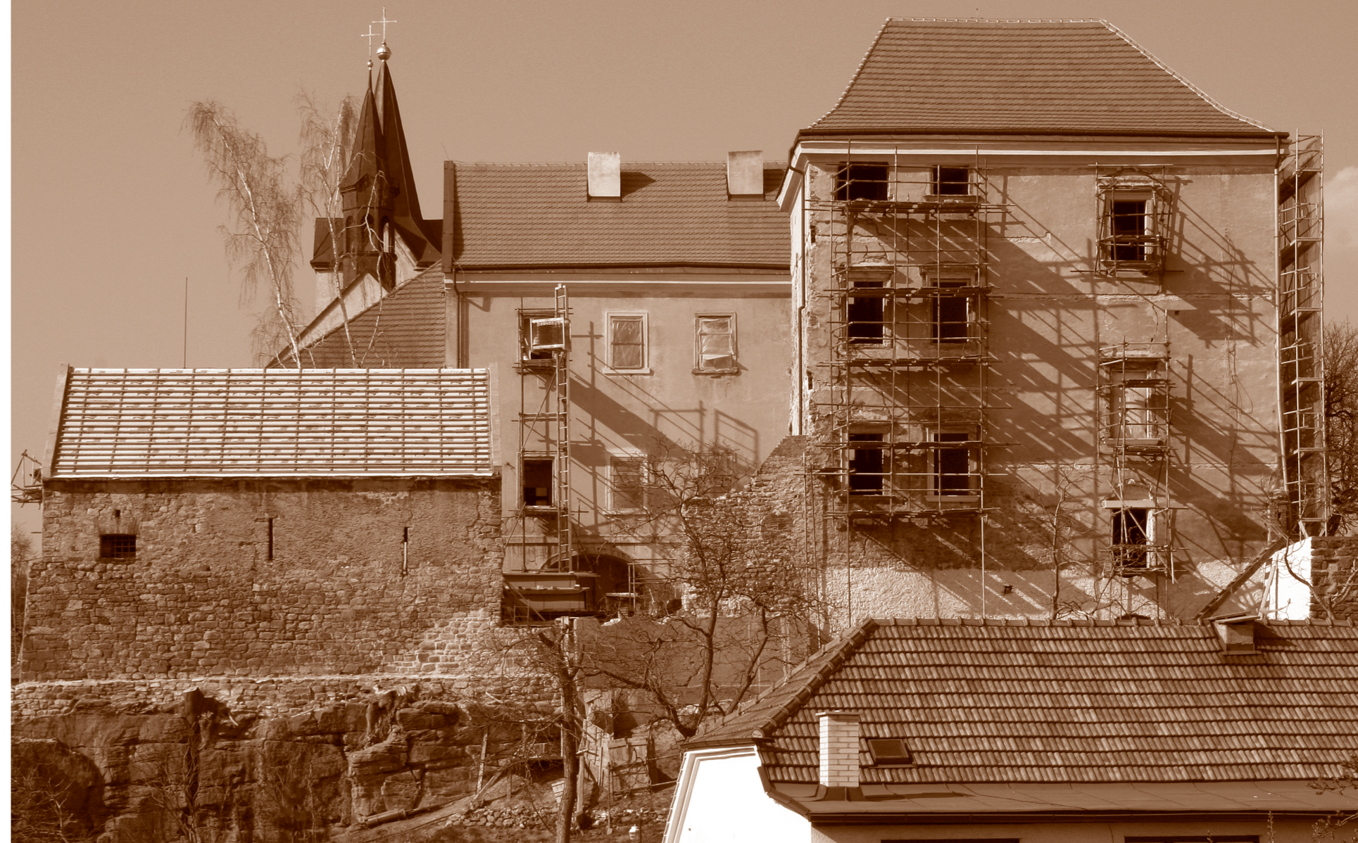
Rekonstrukce zámku, pohled z jihu, 2006–2008
